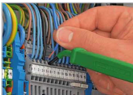
Откройте зажим с помощью рабочего инструмента.
